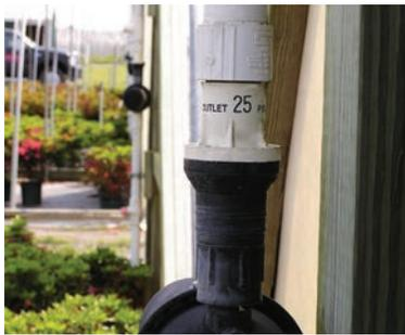
El PR-HF (Regulador de presión de alto caudal) es ideal para instalaciones que requieren caudales altos de 10 a 32 gpm (2271 a 7268 l/h), incluyendo aspersores de cobertura total y distribuidores de bajo volumen.
